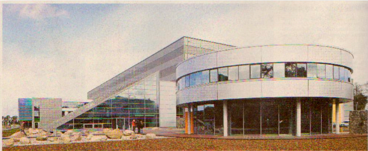
Nach einer Bauzeit von 14 Monaten ist das neue Forschungszentrum in Stade jetzt fertig. Der Bau kostete rund 26,3 Millionen Euro, einen Großteil davon finanzierte das Land Niedersachsen. Mehr als 98 Prozent der Fläche sind bereits langfristig vermietet, nur noch wenige Büros sind frei. Foto: Ingo Wegner/dpa
